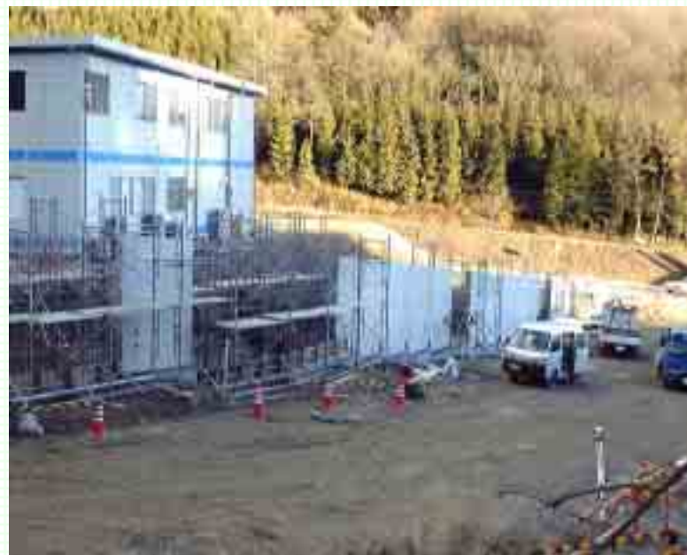
壁 ようへき （擁壁）の設置工事の様子
