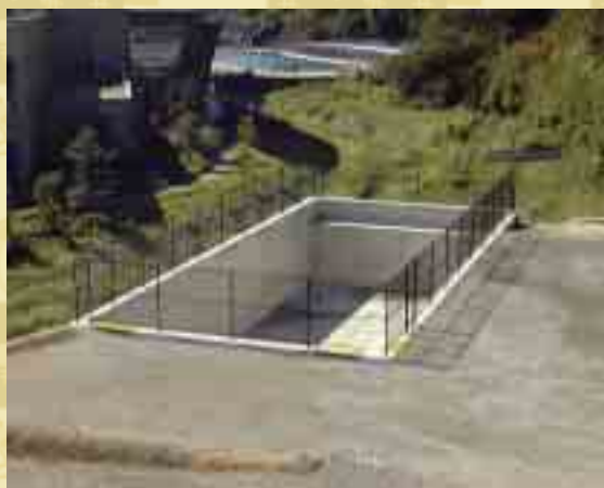
完成した沈砂池の様子
