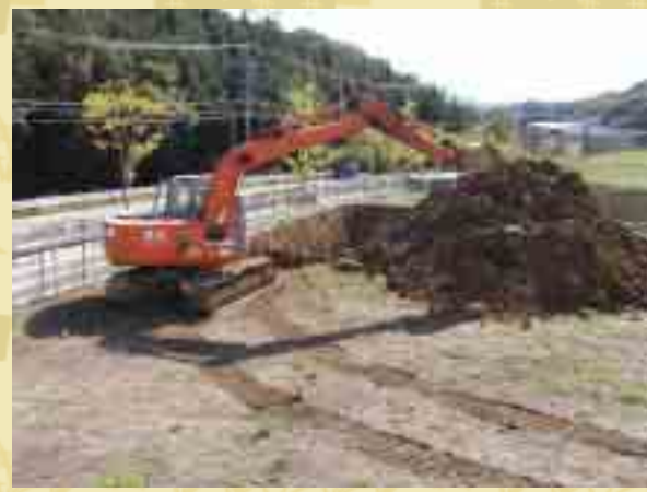
水路を付け替える作業の様子
