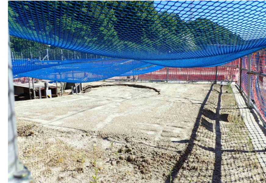
2025/5/14 換気立坑埋め戻し面
