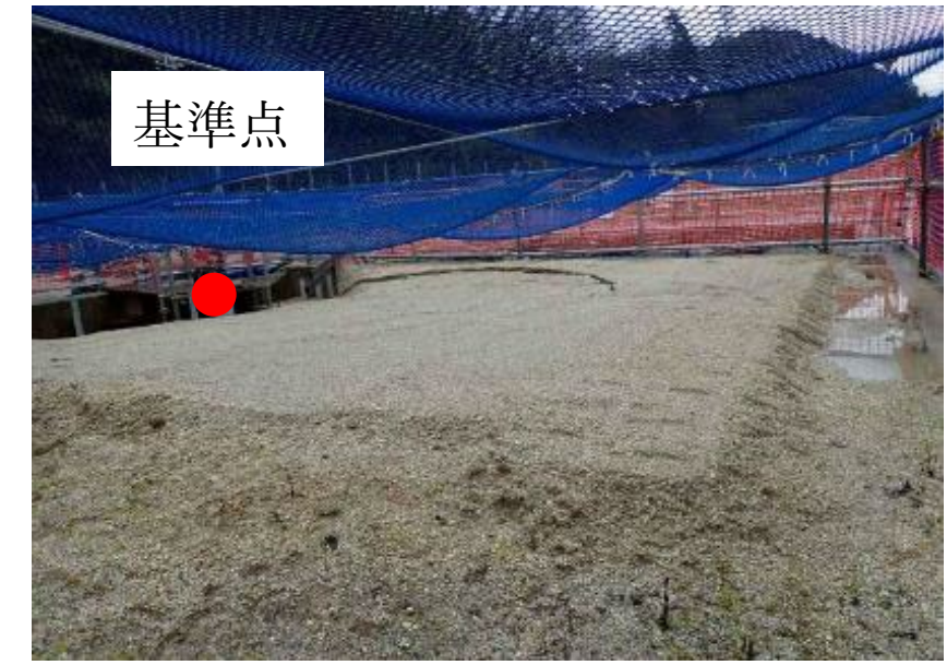
2024/3/29 換気立坑埋め戻し面
