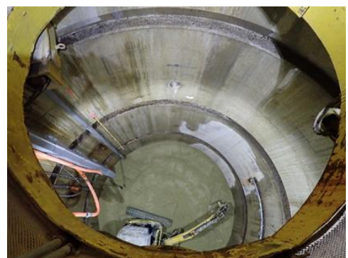
換気立坑深度 90m 付近 (2021.4.7)
