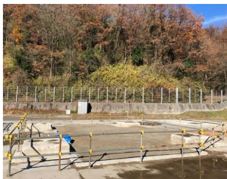
主立坑埋め戻し完了後の状況 (2021.12.9)
