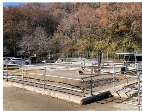
換気立坑埋め戻し完了後の状況 (2021.12.9)
