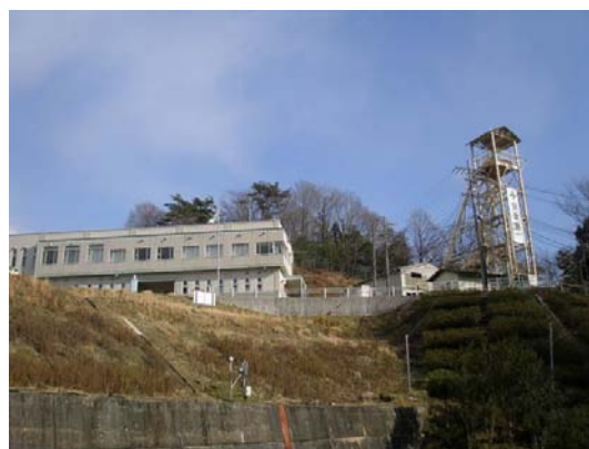
管理棟と調査立坑櫓
