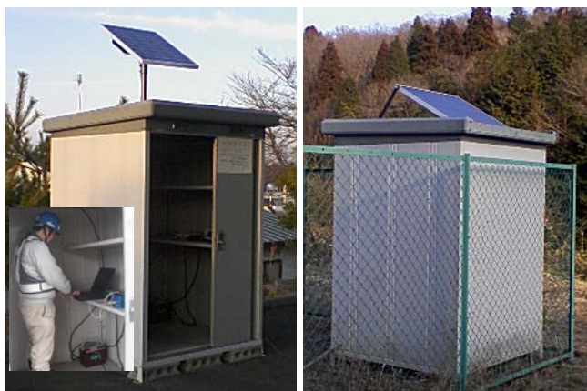
地下水の圧力(水圧)観測
