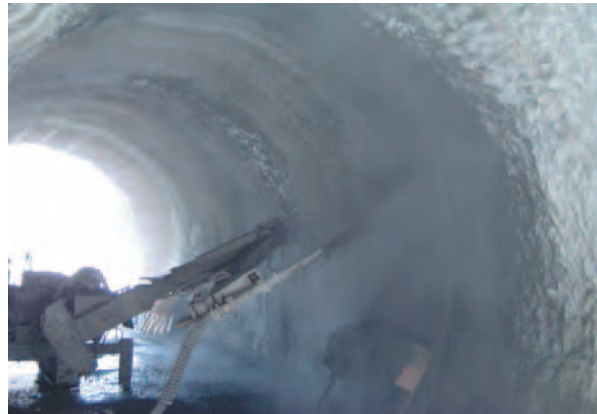
低アルカリ性コンクリートの吹付試験
