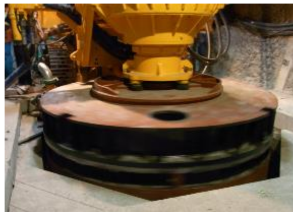
外掘りケーシング掘削状況
