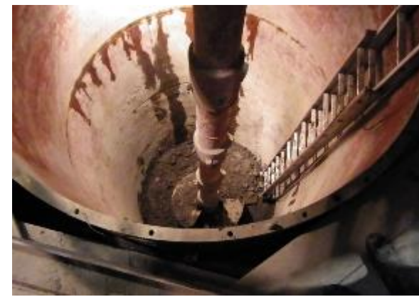
中掘りオーガー掘削状況
