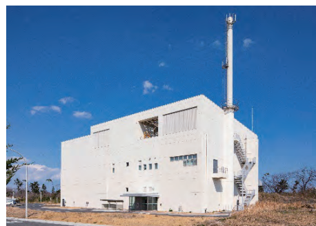
OWTF 全体外観写真 Overview of OWTF
