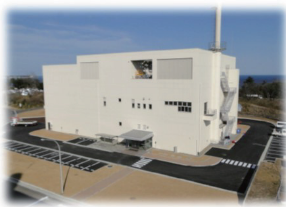
▲OWTF外観（建設中）
