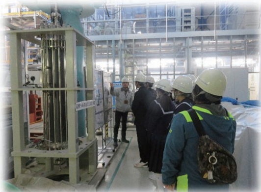
▲ 連続水素製造試験装置
