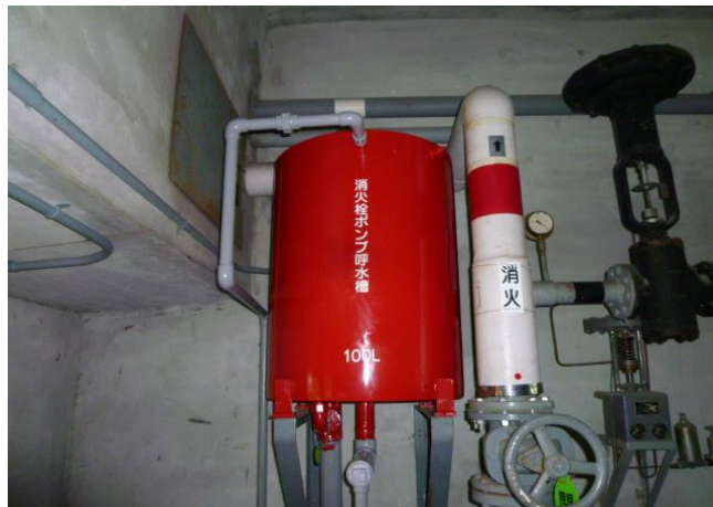
写真 2.1.14-2 第3研究棟消火栓ポンプ呼水槽更新工事
