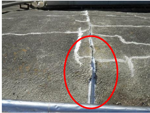
写真 2.1.17-2 タンクヤード法面補修作業
