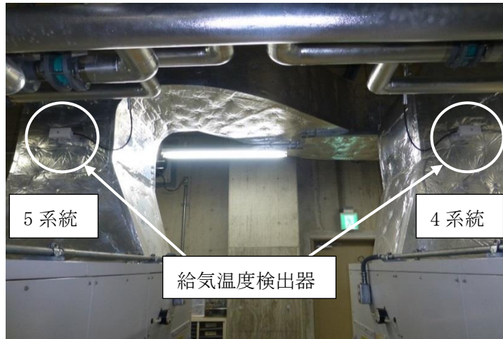
写真 2.1.10-2 4 及び 5 系統用給気温度検出器設置後
