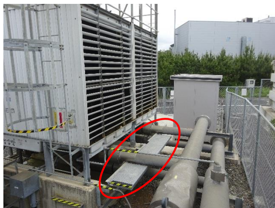
写真 2.1.21-4 3GeV シンクロトロン棟 冷却塔清掃用足場
