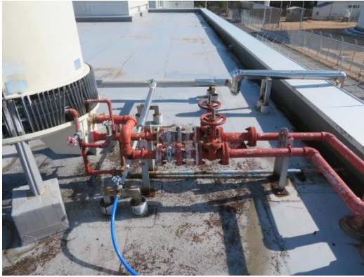
写真 2.1.3-3 補修前の給水配管
