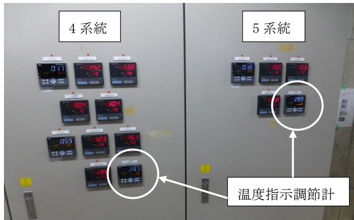
写真 2.1.10-2 4 及び 5 系統用給気温度検出器設置後
