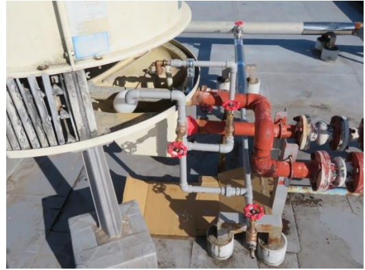
写真 2.1.3-4 補修した給水配管
