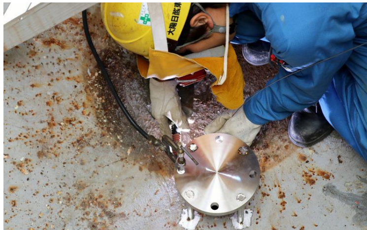
写真 2.1.20-1 蒸発器内への邪魔板溶接状況
