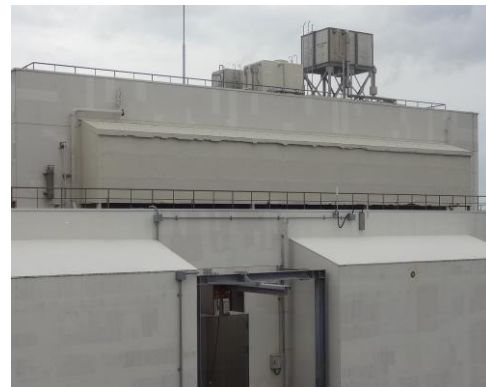
写真 2.1.5-2 外気取入フード補修後
