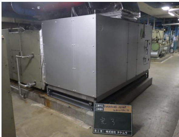
写真 2.1.12-1 給気第1・2系統空調機ファンセクション更新後
