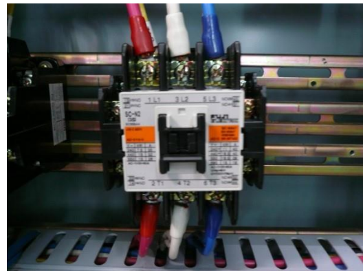
写真 2.1.3-2 更新した電磁開閉器
