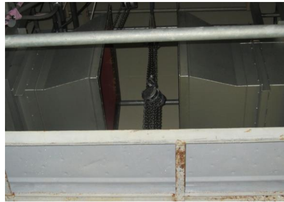
写真 2.10.4-2 既設ダンパ撤去
