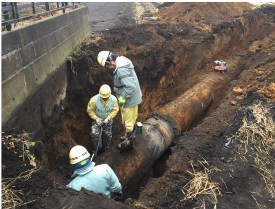
写真 2.10.8-1 導水管周囲掘削状況
