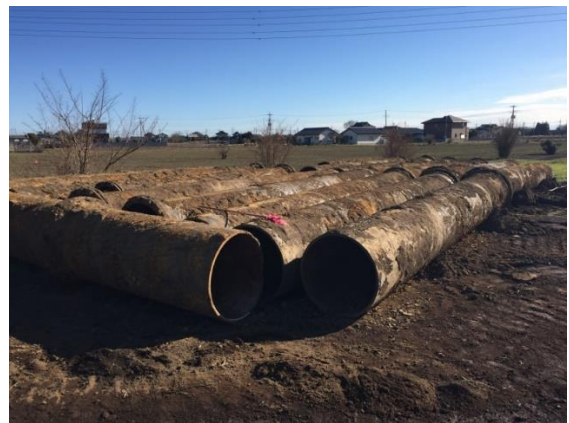
写真 2.10.8-2 撤去した導水管
