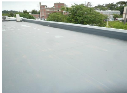
写真 2.10.1-2 ホットラボ 屋上防水 補修後
