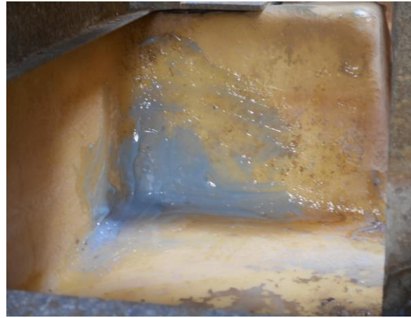
写真 2.1.7-3 補修剤塗布後の状況
