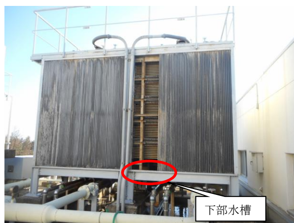
写真 2.1.7-1 冷却塔全景
