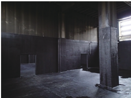
写真 2.1.26 冷却塔ポンド耐震壁の新設前
