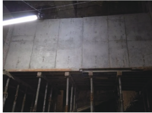
写真 2.1.23 基礎梁増打ち補強
