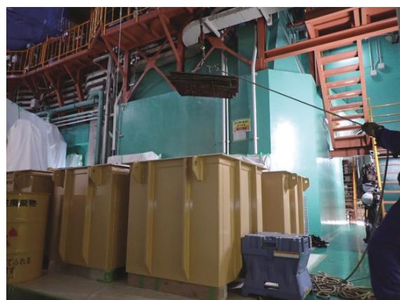
写真 2.1.18 解体廃棄物封入状況
