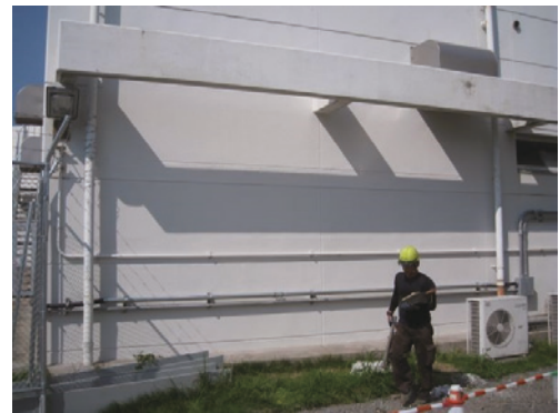
写真 2.1.25 コンプレッサ棟開口閉塞後 (川又 諭、鈴木 真琴)
