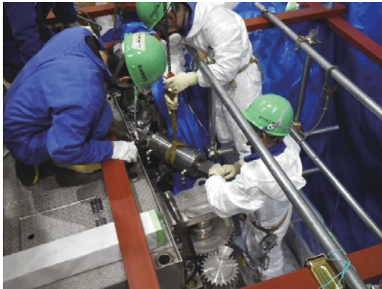
写真 3.1.2.1 駆動用水圧シリンダの取り付け
