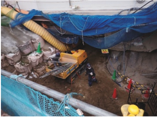
写真 2.1.22 実験利用棟地下部掘削後
