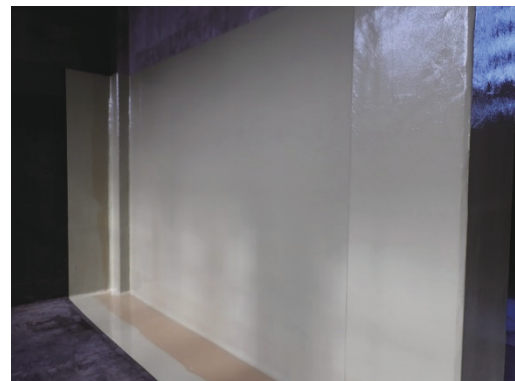
写真 2.1.27 冷却塔ポンド耐震壁新設後
