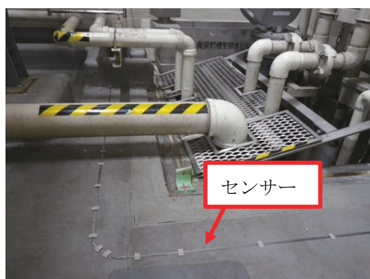
写真 2.1.1 漏えい検知器センサー及び検知器設置場所（廃液貯槽室）
