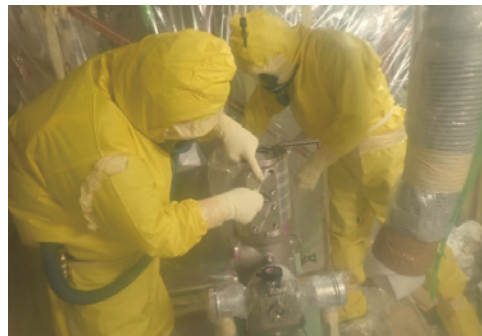
写真 3.1.2.6 ヘリウム圧縮機分解点検の様子
