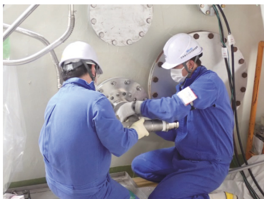
写真 2.1.4 給水用ホース接続口設置状況
