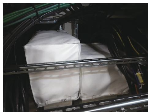
写真 2.1.3 ケーブルの分離設備の設置前後（原子炉建家側）
