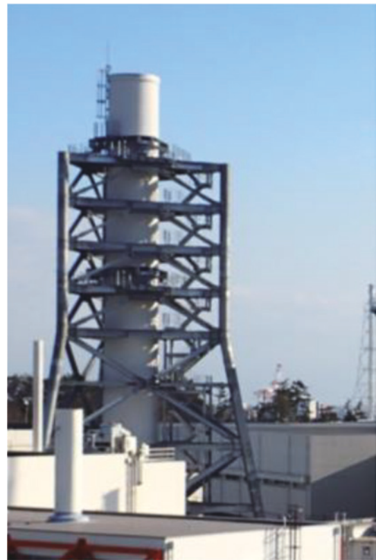
写真 2.1.14 排気筒の耐震改修工事後 (山田 佑典)
