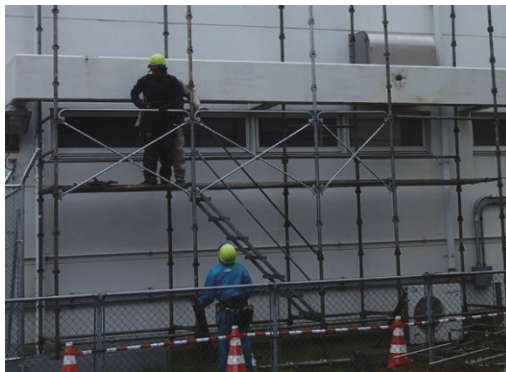
写真 2.1.24 コンプレッサ棟開口閉塞前
