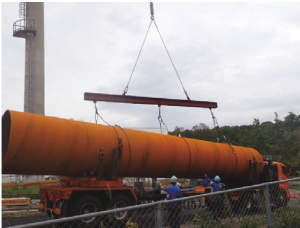
写真 2.1.8 杭鋼管全体
