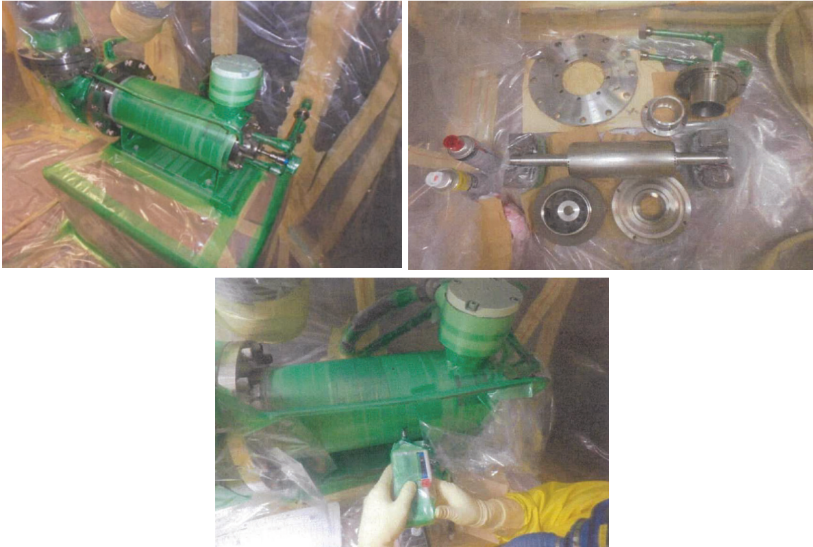
写真 3.1.2.3 重水ポンプ分解点検の様子
