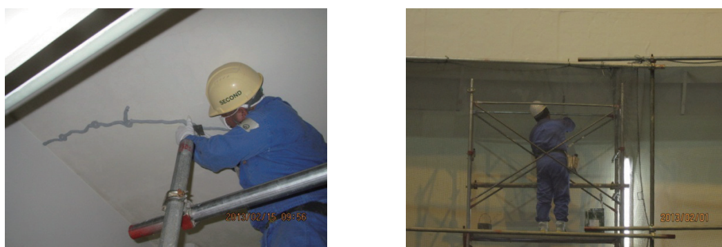
図 2.1.18 ひび割れ部の補修工事
