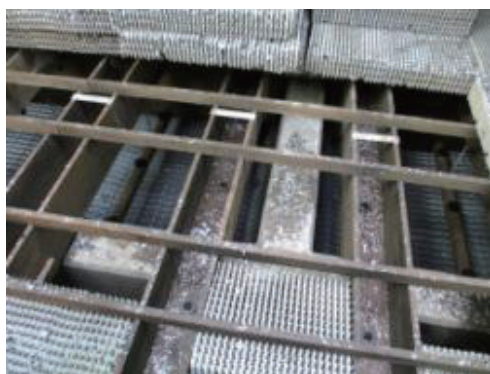
図 2.1.9 エリミネータの交換作業
