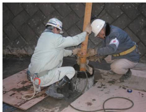
図 2.1.20 ディープウェルの施工
