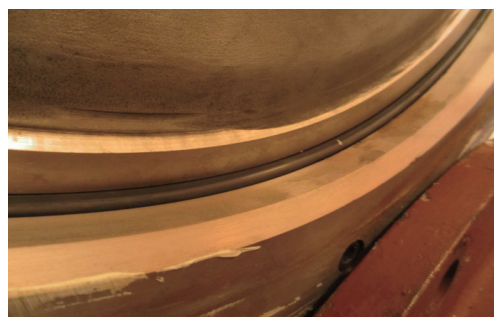
図 2.1.6 交換後シートパッキン
