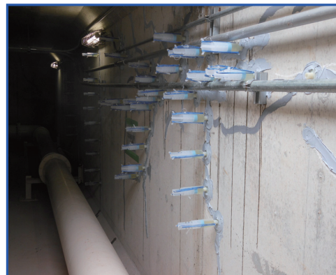
図 2.2.3 共同溝(B)エポキシ注入
