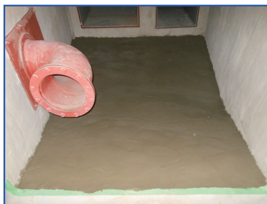
図 2.2.4 排気風洞 樹脂モルタル補修
