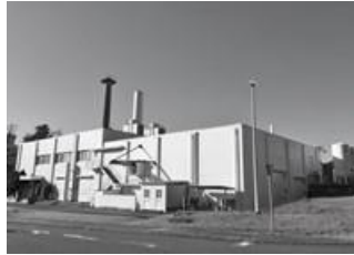
トリチウムプロセス研究棟
