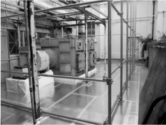
屋外のグリーンハウスの設置状況 (単管による骨組み)
