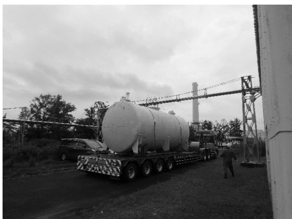
低床トレーラーでの移送（蒸気配管下）
