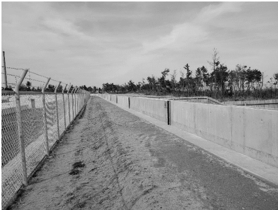
津波防護壁外観
