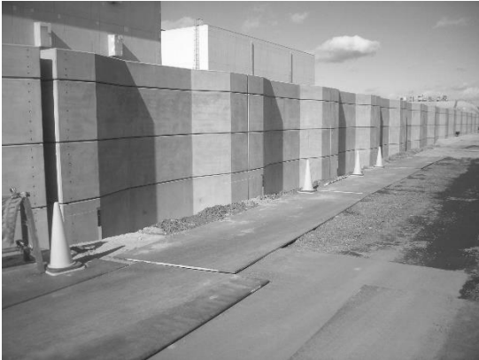
プレキャストコンクリートの設置 (4段積み)
