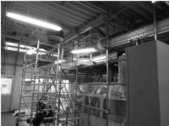
屋内の足場の設置状況
