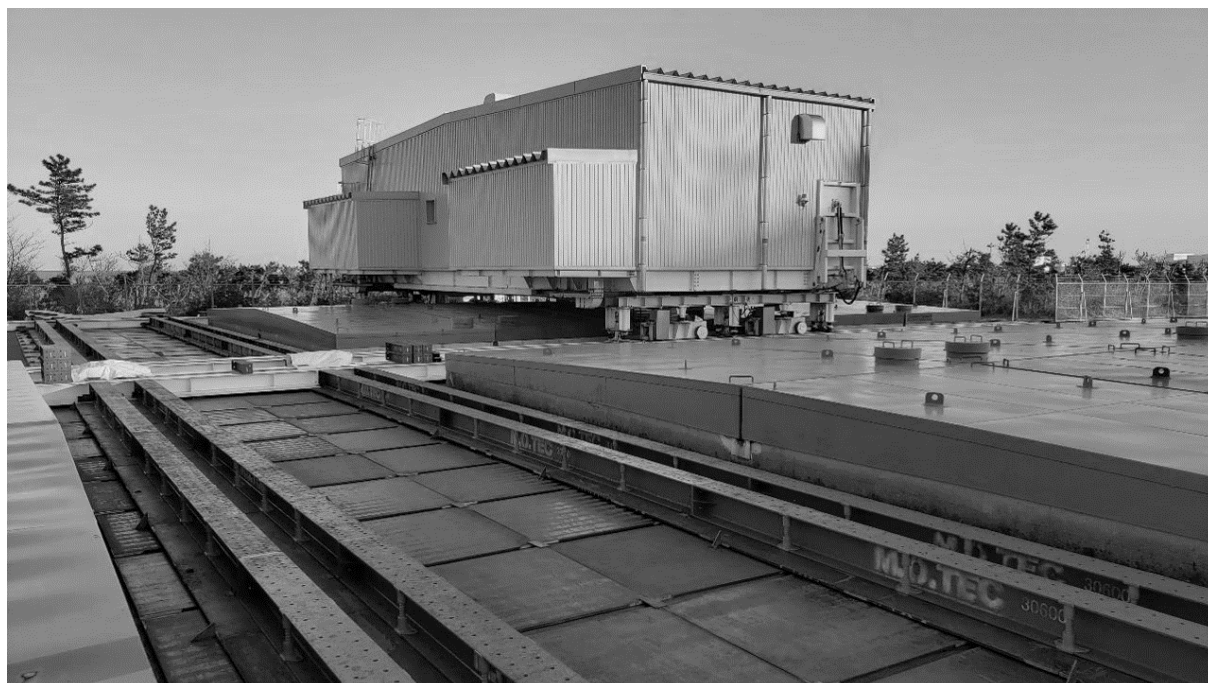
図 3.6.1-6 上屋及び東西方向レール敷設写真
