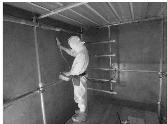
Pu セルの汚染検査
