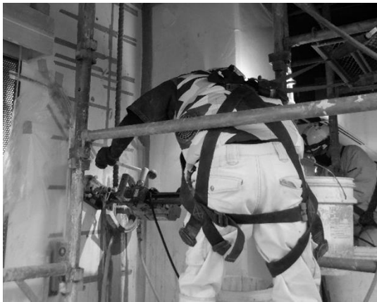
耐震スリット コア抜き
