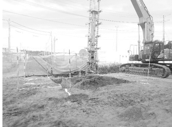
重機（パワーブレンダー）による地盤改良
