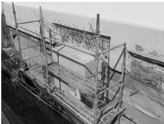
柱の増し打ち 外観
