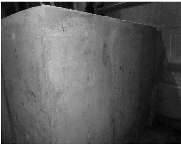
場所打ちコンクリート杭 外観
