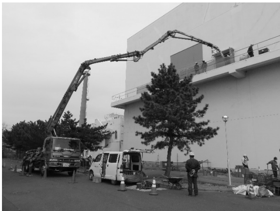
梁の増し打ち コンクリート打設
