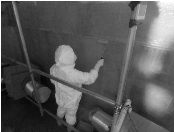
Pu セルの汚染固定
