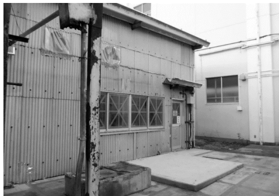
フィルタユニット撤去状況
