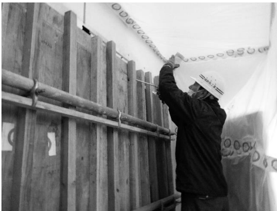
開口閉塞 型枠建込み
