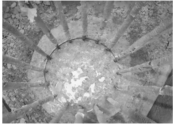
場所打ちコンクリート杭 杭の打込み (2/2)
