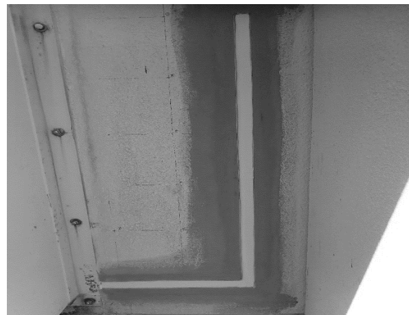
耐震スリット 外観
