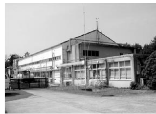
放射性廃棄物処理場 (液体処理場)
