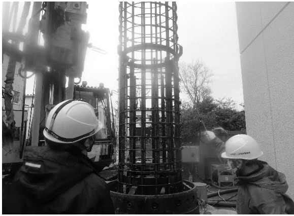
場所打ちコンクリート杭 杭の打込み (1/2)
