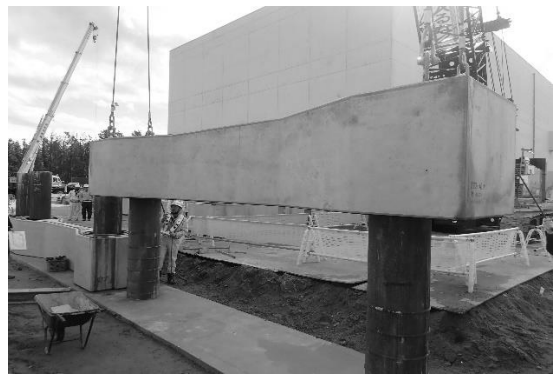
プレキャストコンクリートの設置
