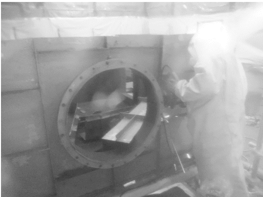
フィルタユニットの切断作業状況
