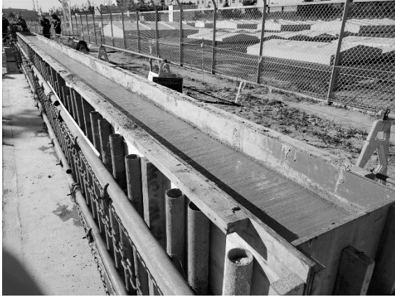
コンクリート打設（壁部）
