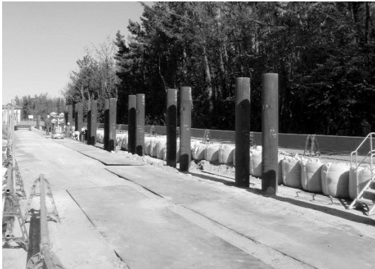
鋼管杭の建て込み
