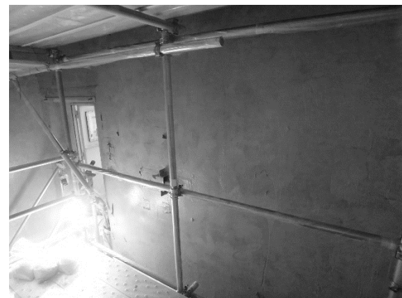
Pu セルの汚染固定後
