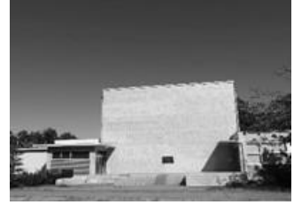
JRR-1 残存施設
