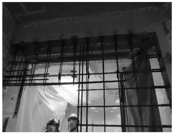
開口閉塞 アンカー打込み
