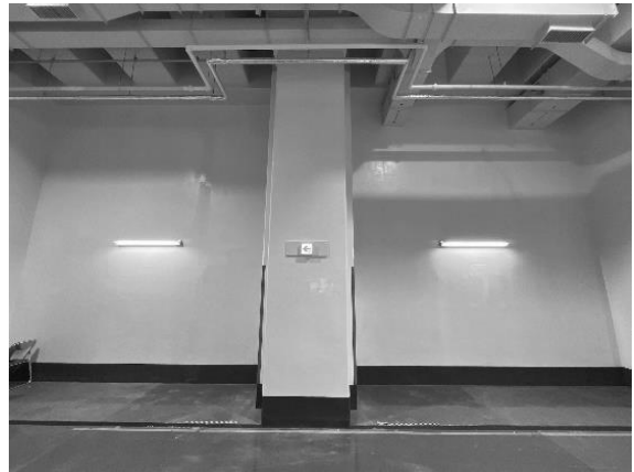
柱の増し打ち 外観
