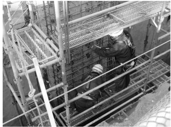
柱の増し打ち 配筋
