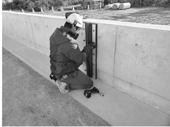
止水材の取付け
