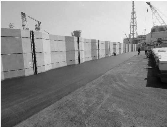
津波防護壁外観
