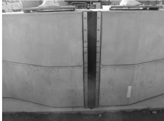
止水材の取付け
