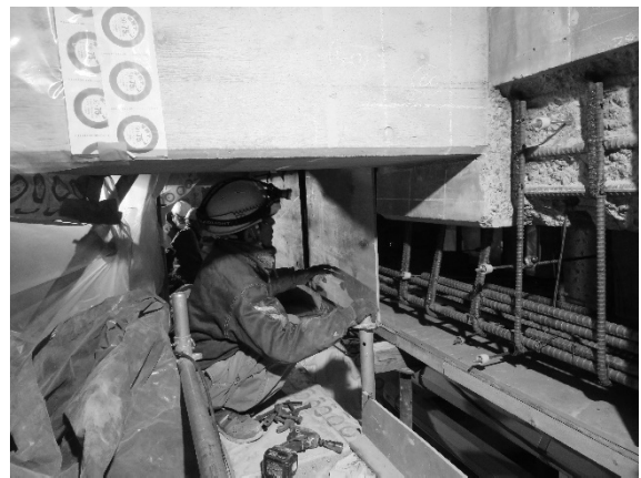
梁の増し打ち 型枠建込み
