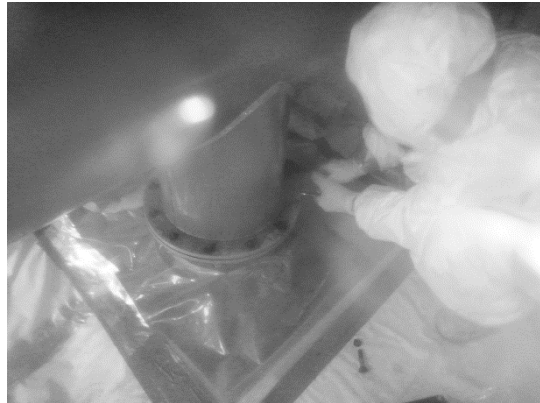
排気ダクトの切断作業状況
