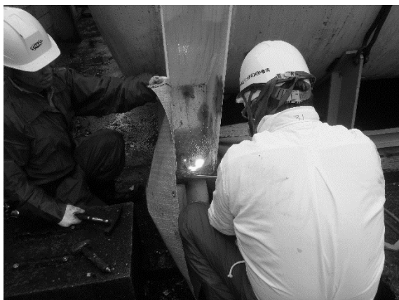
ガス溶断で脚部の切断
