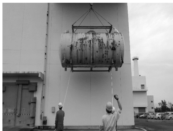
解体分別保管棟解体室への搬入
