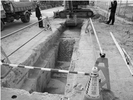
基礎形状に掘削
