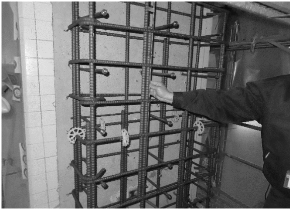
柱の増し打ち 配筋
