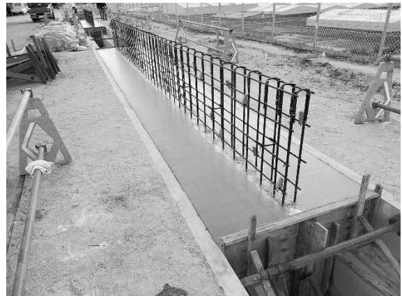
コンクリート打設（基礎部）
