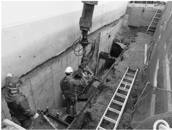
柱の増し打ち 根伐掘削
