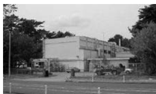
VHTRC 同位体分離研施設
