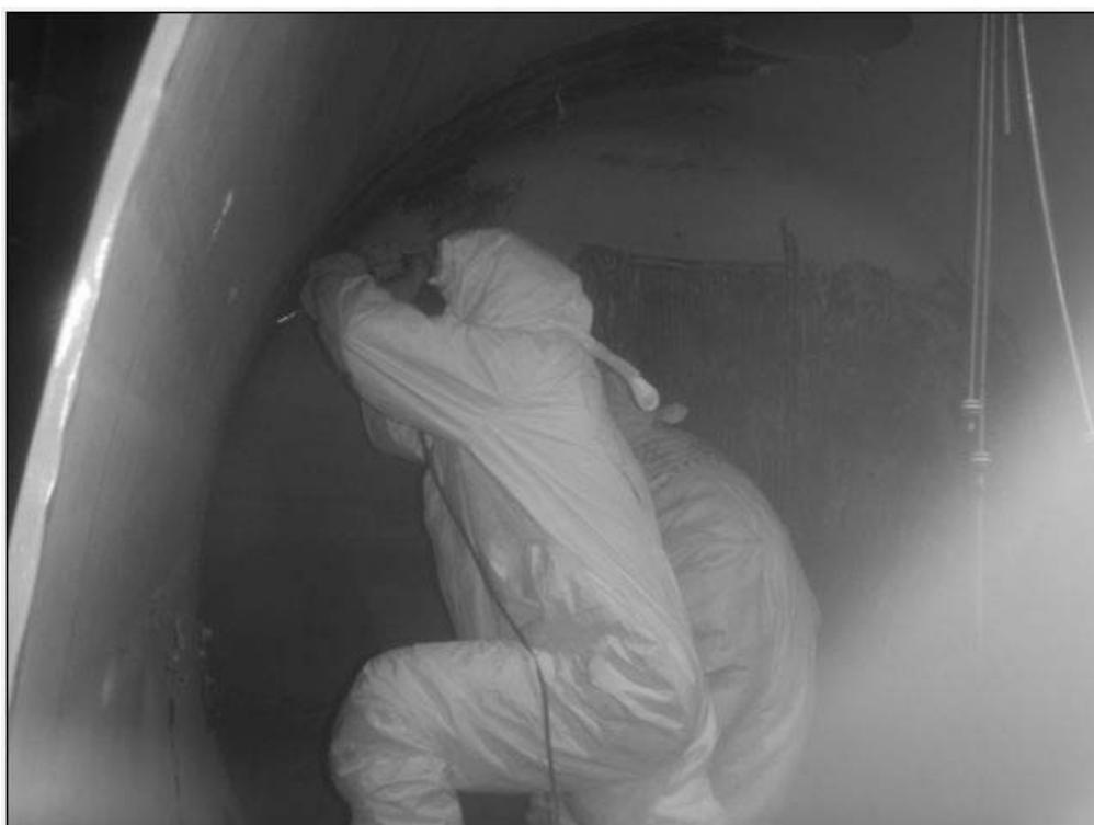
図 3.4.2-4 廃液タンク内面のライニングの小型はつり機による分離作業
