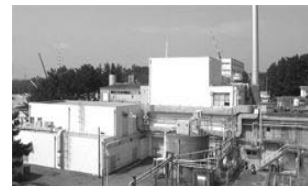
再処理特別研究棟
