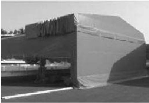
(対象物取出し作業用上屋)
