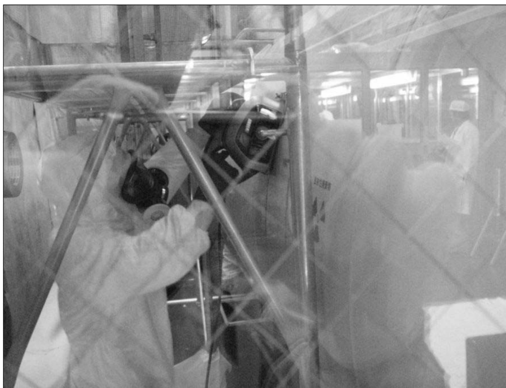
図 3.4.2-3 廃液タンクのチップソーによる切断作業
