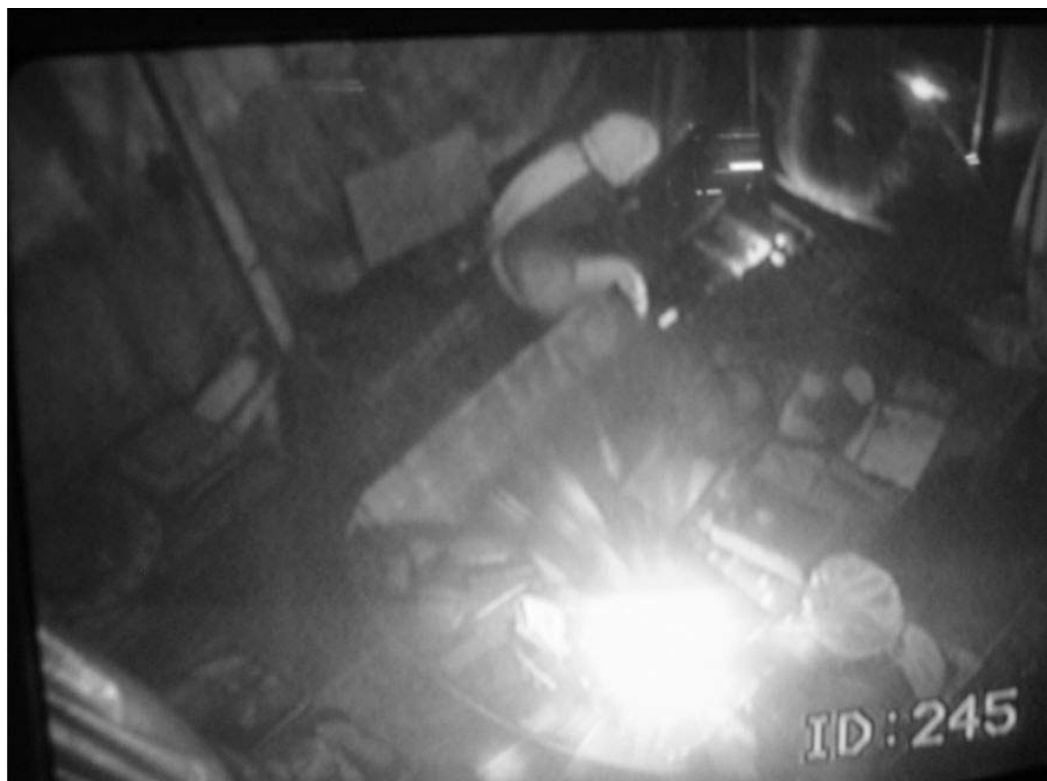
図 3.4.2-5 プラズマ切断機、ガス溶断機による切断作業
