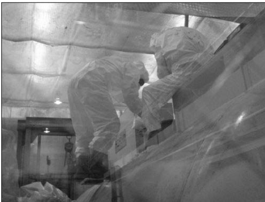
図 3.4.2-2 廃液タンクの内部確認
