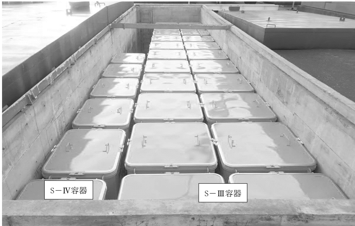
図IV-3-5 ピットへのS-III容器及びS-IV容器の収納状況
