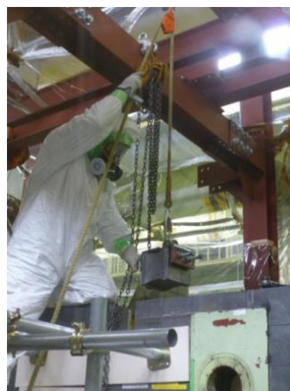
鉛ブロックの解体
