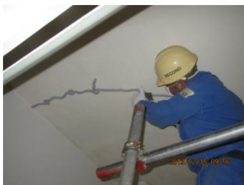
図Ⅲ-1-1 ひび割れ部の補修工事
