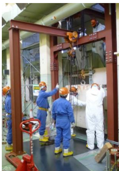
背面扉の引抜き
