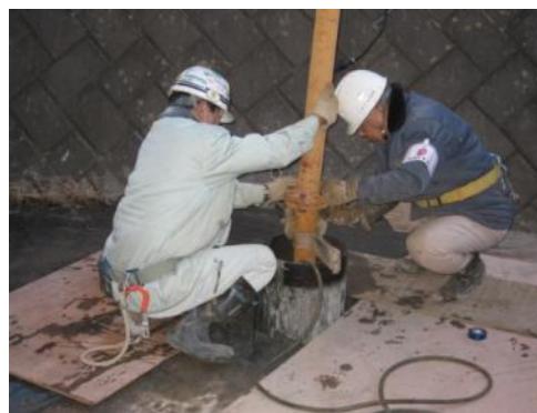
図Ⅲ-1-3 ディープウェルの施工
