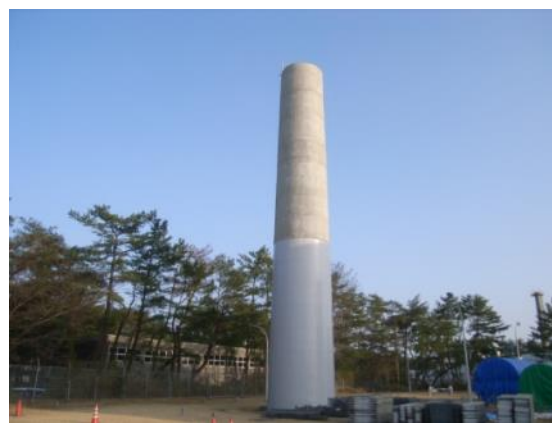
一部が倒壊した排気筒の補修後
