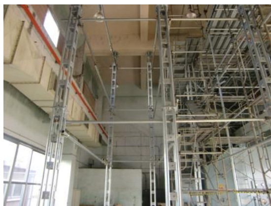
15ton クレーン室の建家補強
