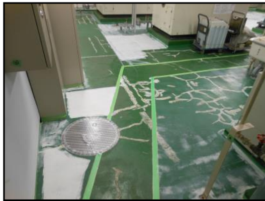
図Ⅲ-1-4 機械室床 樹脂モルタル補修
