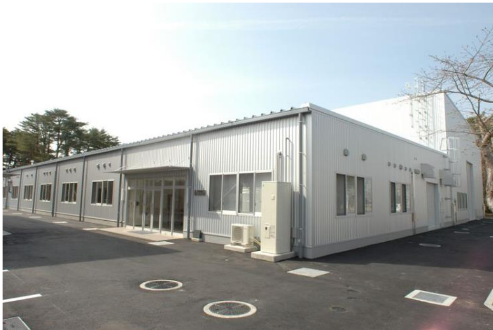
図Ⅲ-1-23 安全基礎工学実験棟の外観
