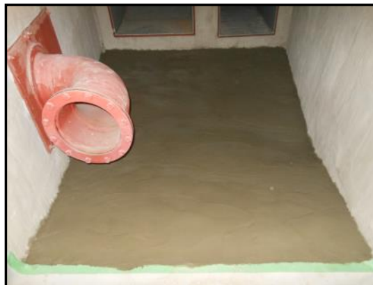
図Ⅲ-1-6 排気風洞 樹脂モルタル補修
