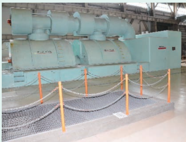
高圧・低圧タービンカバー解体前後の様子
