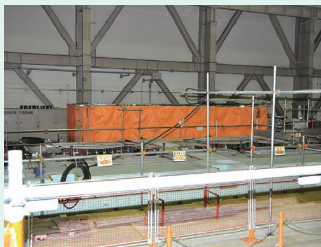
高圧・低圧タービンカバー解体前後の様子
