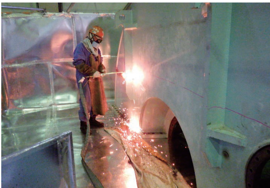
低圧タービン外部車室のガス溶断作業の様子(2023年11月)
