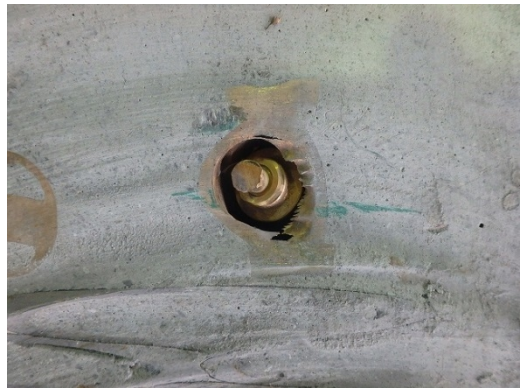
図 5-16 試験体 No.10 充填状況 (P ロート流下時間 50 秒)
