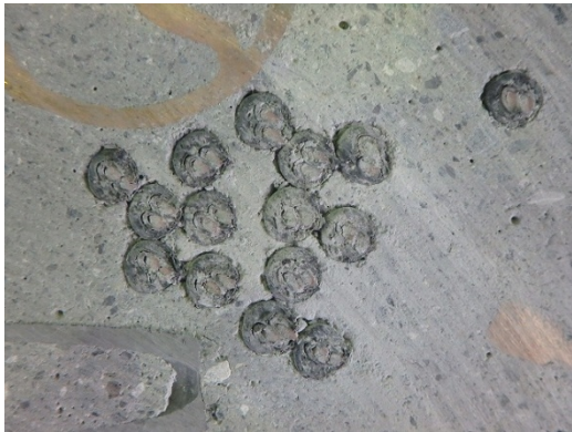
図 5-5 試験体 No.1 充填状況 (P ロート流下時間 20 秒)
