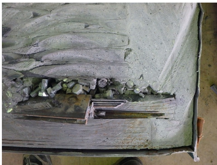
写真 42 試験体の断面(充填材の P ロート流下時間 44 秒)の未充填部(ボルト・ナット部)拡大
