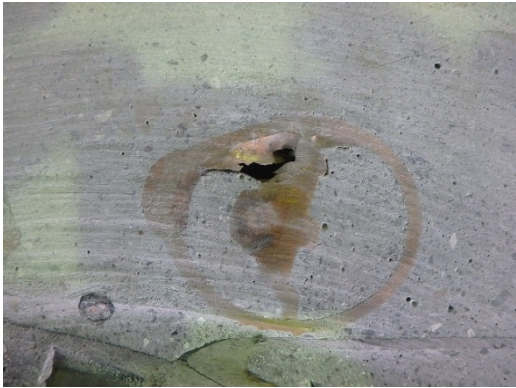
図 5-13 試験体 No.1 充填状況 (P ロート流下時間 20 秒)
