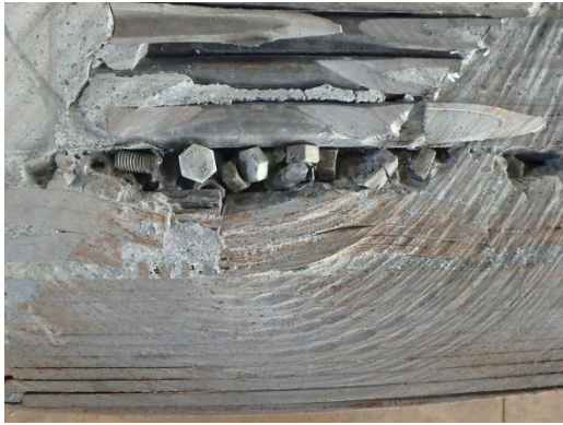
図 5-9 試験体 No.1 充填状況 (P ロート流下時間 20 秒)
