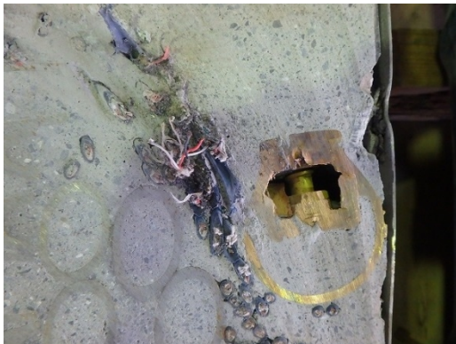
図 5-15 試験体 No.7 充填状況 (P ロート流下時間 40 秒)
