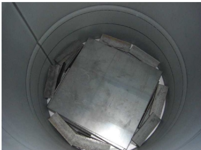
写真1 ドラム缶底部に金属板を収納した状況 (金属板周囲にはアングル材を配置)
