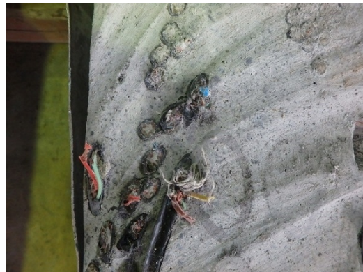
図 5-6 試験体 No.4 充填状況 (P ロート流下時間 30 秒)
