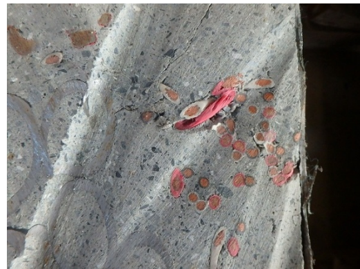
図 5-8 試験体 No.10 充填状況 (P ロート流下時間 50 秒)
