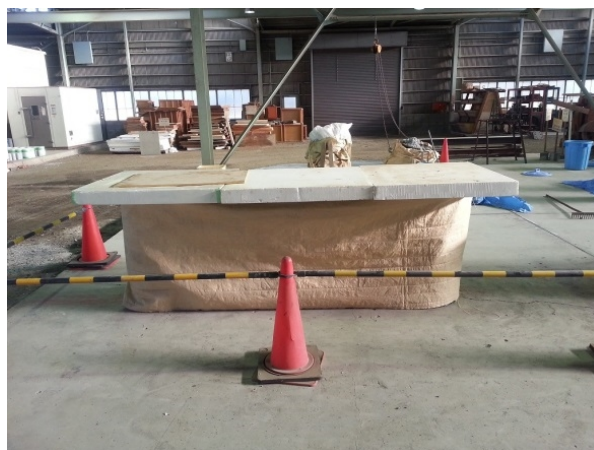
写真 21 充填後の養生の状況
