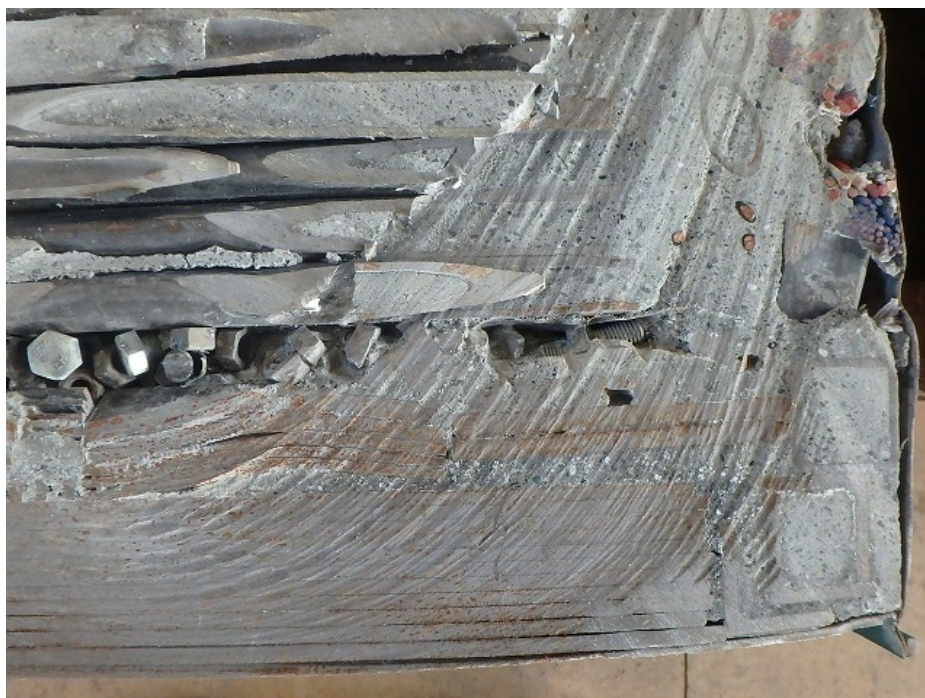
写真 38 試験体の断面(充填材の P ロート流下時間 17 秒)の未充填部(ボルト・ナット部)拡大
