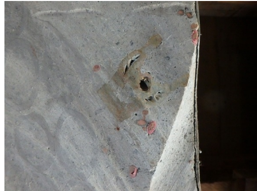
図 5-14 試験体 No.4 充填状況 (P ロート流下時間 30 秒)
