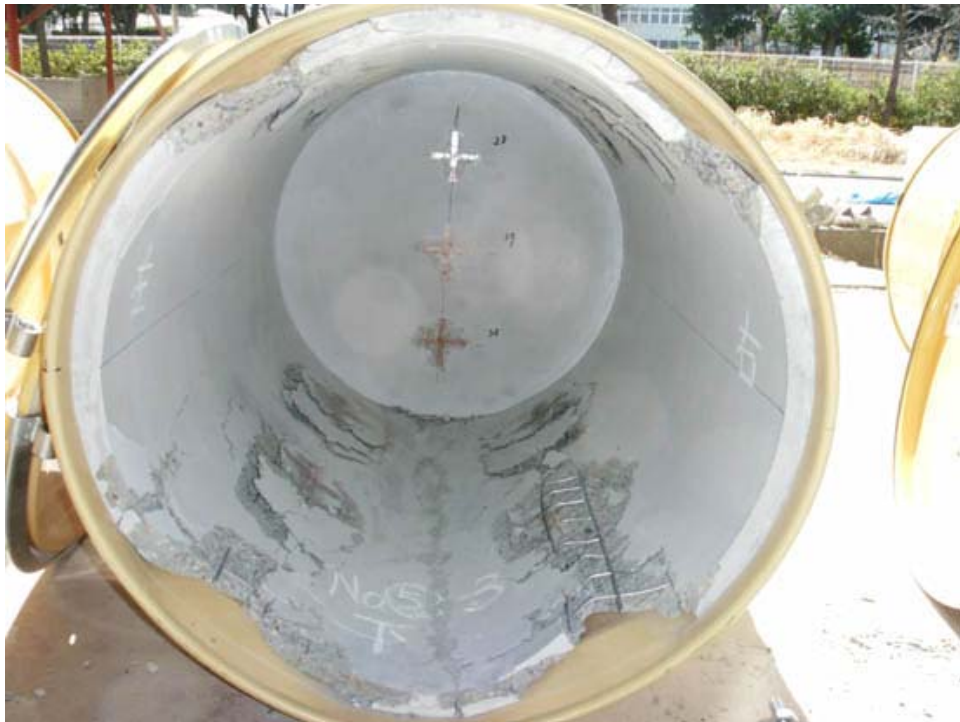
図 68 D-20(試験体No.2)の裁荷後の変形の状況(2/2)
