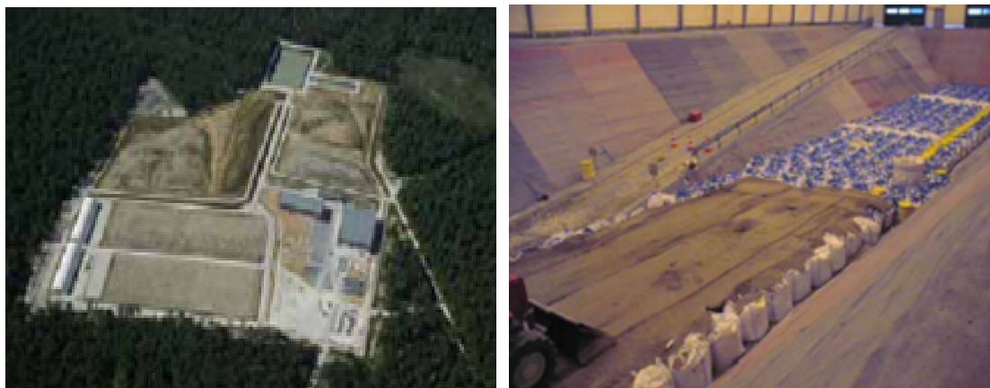
写真 2-2 モルビリエ極低レベル処分場とその素掘りトレンチ処分 (3)(4)
