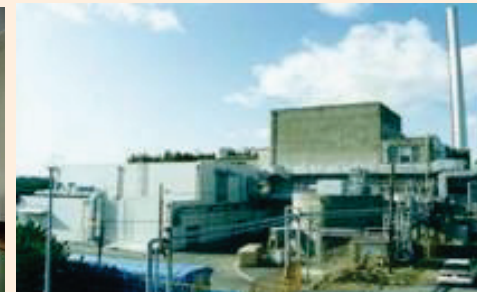
解体中の原子力施設
