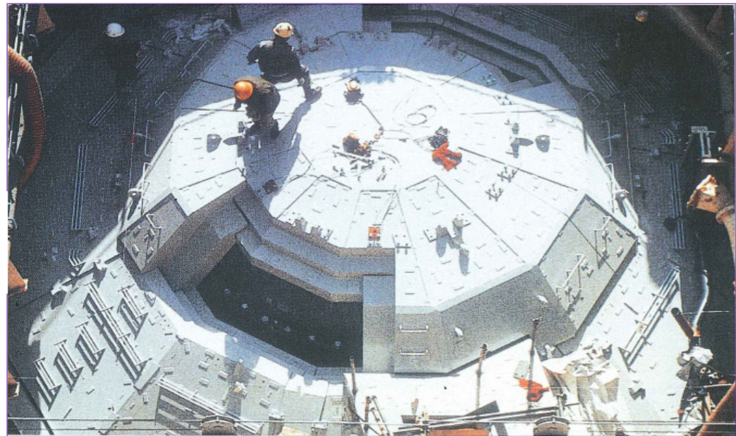
格納容器 上部遮へい体の搭載
