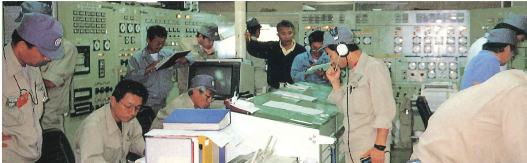
航海中の制御室
