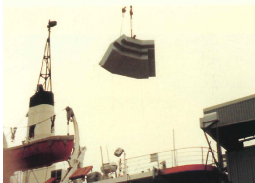
格納容器 上部遮へい体の搭載
