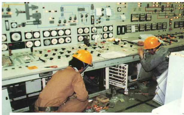
中央制御盤の改修
