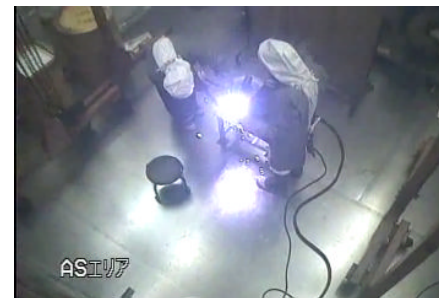
実汚染機材の切断試験作業概念(上)と実際の作業状況(右)(JPDR廃材の例)
