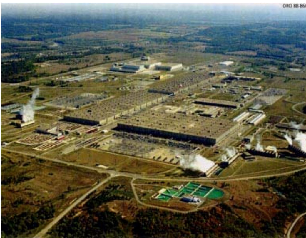
写真1 ポーツマス濃縮工場
