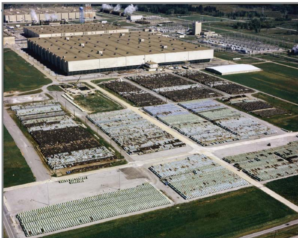
写真 7 パデューカ濃縮工場の劣化 UF 6 シリンダーの保管状況 41)
