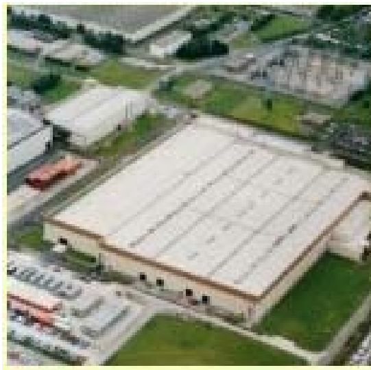
カーペンハースト濃縮工場E23施設
