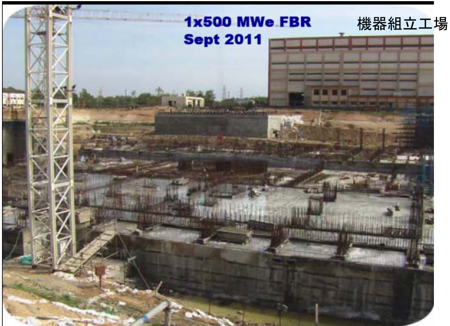
基礎コンクリートの打設状況
