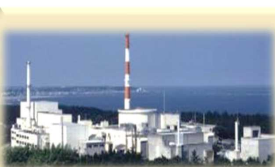
高速実験炉「常陽」
