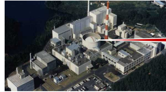
高速実験炉「常陽」
