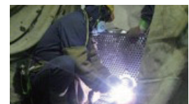
原子炉周辺機器の解体
