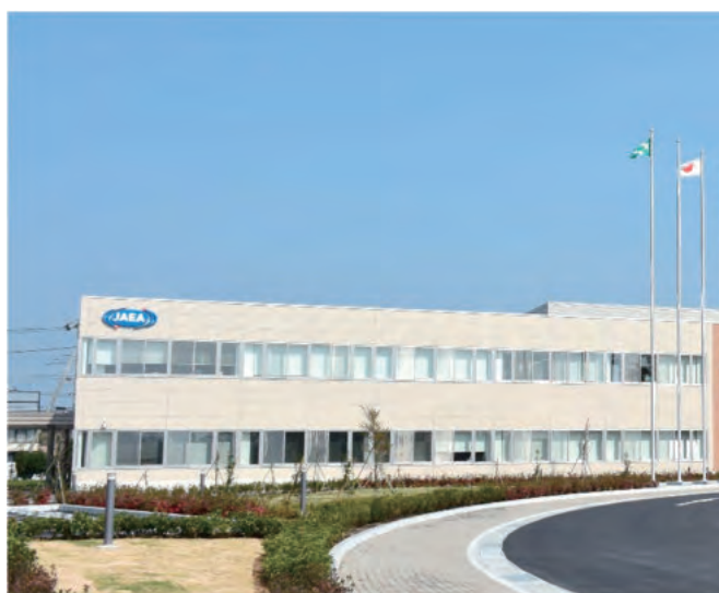
本部 総合管理棟
