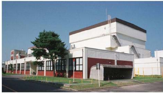
JRR-4建家外観
