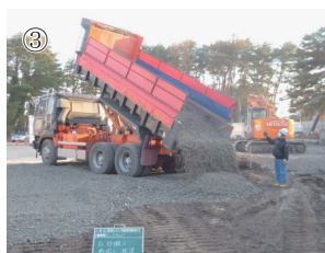
③ 建家解体後の 埋戻し材として利用
