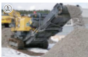
① 破碎による資源化加工 (自走式破碎機による破碎)
