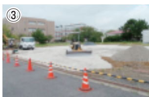
③ 駐車場整備のための 路盤材として再利用
