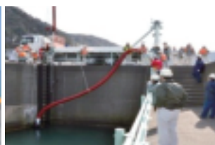
原子炉補助冷却海水ポンプ 代替ポンプ設置訓練
