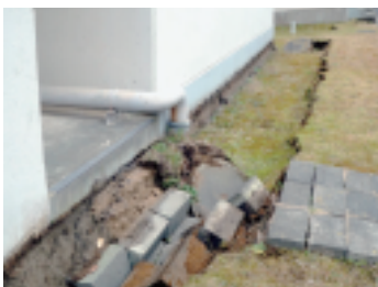
NUCEF(燃料サイクル安全工学研究施設)建家周辺の地盤沈下場所の補修を実施
