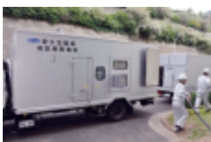
電源車接続訓練
