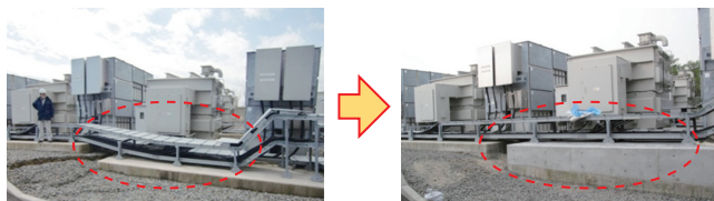
地盤沈下した変圧器基礎部を修復
