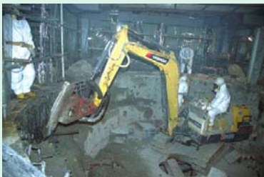
二次破碎の状況
