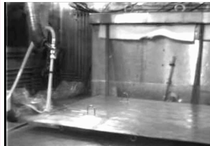
床面の除染状況
