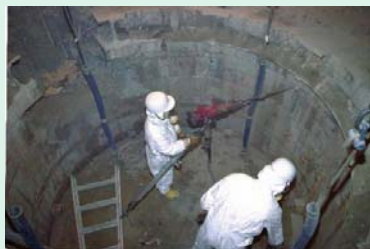
削岩機による削孔
